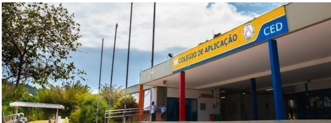
Figura 1 – Fotografia da fachada do Colégio de Aplicação da UFSC
